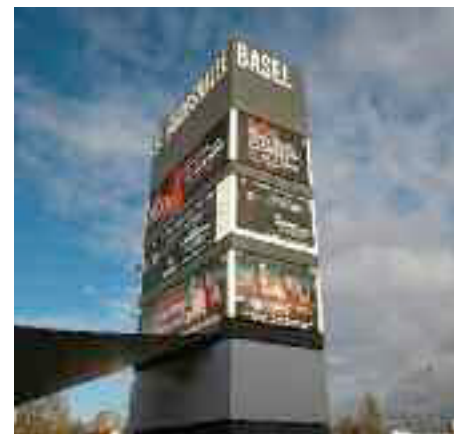
St. Jakobshalle Basel
